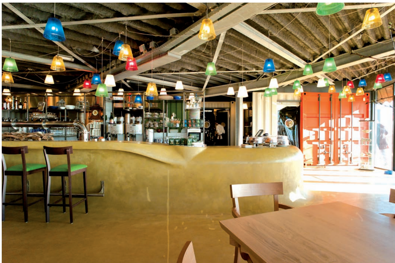
Met alle poëzie gaat het proza van de constructie goed samen: stalen H-kolommen en -liggers en een staalplaat dak. Achter de bar de 'containers' met techniek, opslag en werkruimtes.
